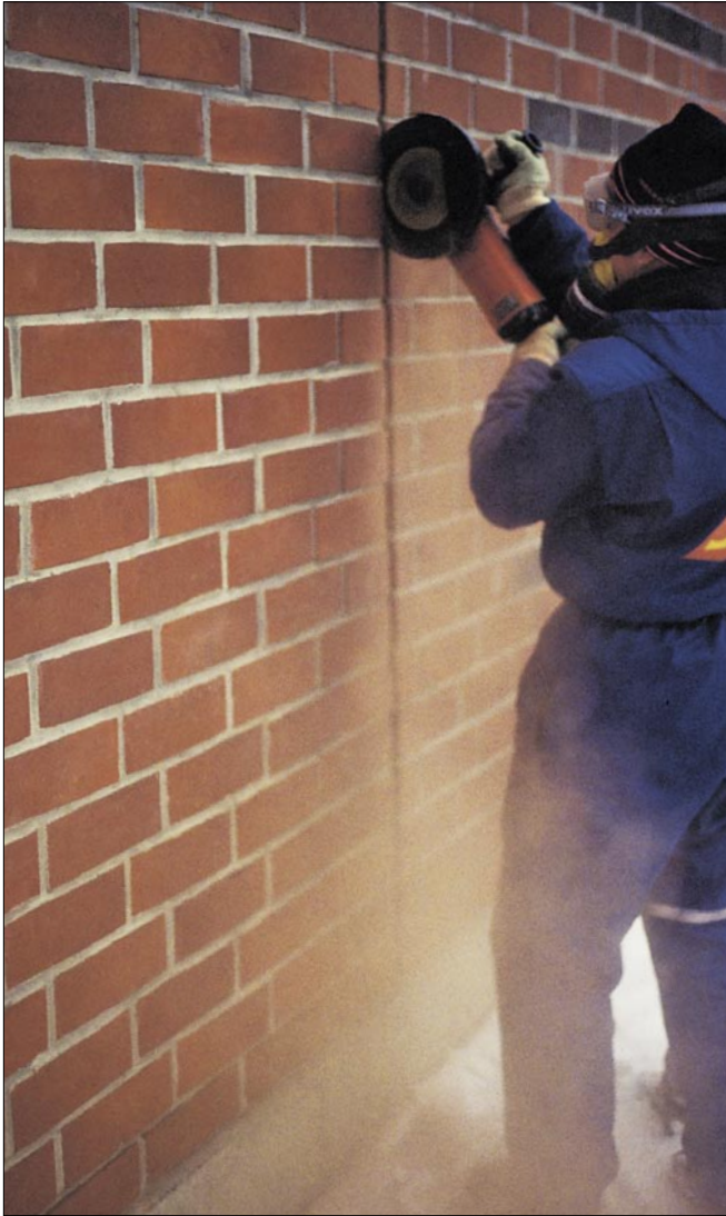
Avatun sauman tartuntapinnat hiotaan huolellisesti vanhasta saumaussmassasta.
