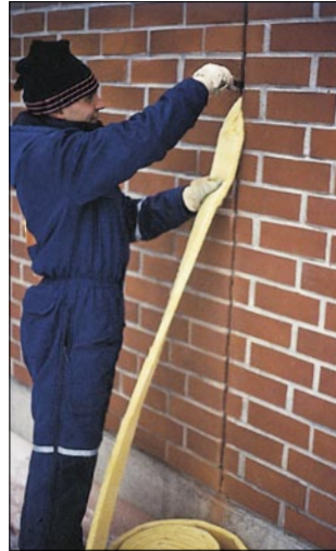
Oikein tehdyssä lisävilloituksessa villan tuuletusuria ei tukita. Saumaan asennetun umpisoluisen polyeteeninauhan avulla saadaan saumalle oikea muoto. Tämän jälkeen suoritetaan primer-käsittely.
