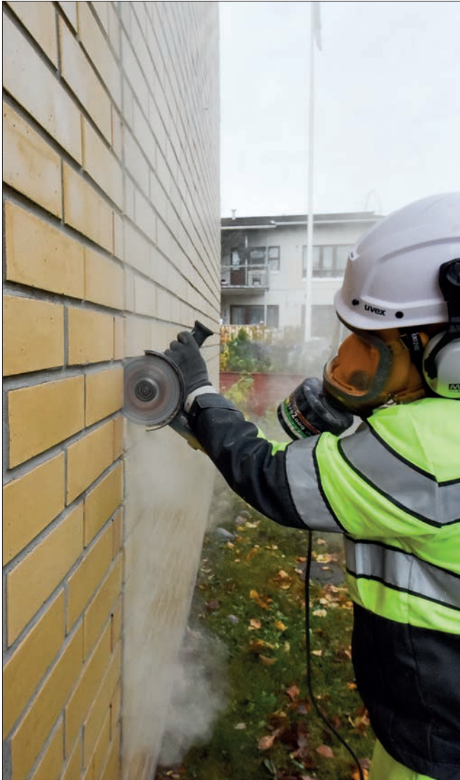
Vanha saumaussmassa poistetaan alustavasti mekaanisesti. Avatun sauman tartuntapinnat hiotaan huolellisesti vanhasta saumaussmassasta.
