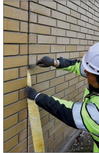
Oikein tehdyssä lisävilloituksessa villan tuuletusuria ei tukita. Saumaan asennetun umpisoluisen polyeteeninauhan avulla saadaan saumalle oikea muoto. Tämän jälkeen suoritetaan primer-käsittely.
