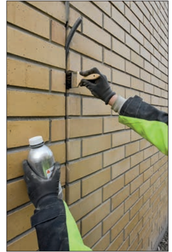
Oikein tehdyssä lisävilloituksessa villan tuuletusuria ei tukita. Saumaan asennetun umpisoluisen polyeteeninauhan avulla saadaan saumalle oikea muoto. Tämän jälkeen suoritetaan primer-käsittely.
