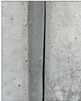
Tartuntapinnoilla on muuttöljyn jäänteitä ja muuta tartuntaa haittaavia tekijöitä.
