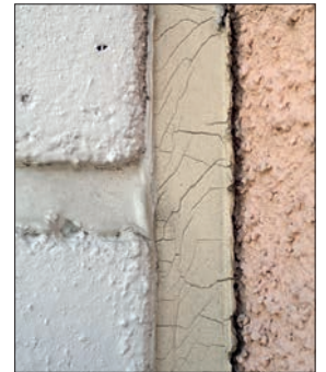
Saumausmassa ei ole saavuttanut tarpeeksi lujaa tartuntalujuutta rapatulle tartuntapinnalle.
