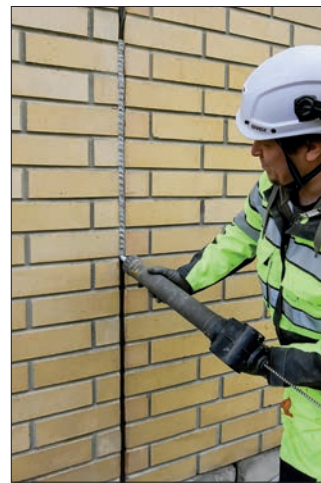
Primerin kuivuttua, sekä tuuletuskoteloiden tai -putkien asentamisen jälkeen, massa pursotetaan saumaan ja painetaan tasoituslastalla tiiviisti tartuntapintoja vasten. Monien käsityönä suoritettujen työvaiheiden jälkeen lopputuloksena on valmis vedenpitävä sauma.
