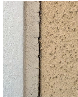
Maalihalkeillut sauman päällä, eikä saumausmassa ole saavuttanut tarpeeksi lujaa tartuntalujuutta.
