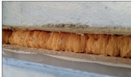
Taustatilan tuuletus on tukittu uretaani-vaahdomassalla.
